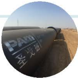
江苏省徐州市重点工程城乡一体化 丰沛原水工程和清水管网项目 DN400-DN1400 300公里
