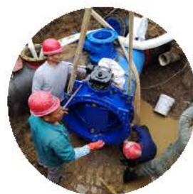
安徽省六安市市政 供水管线工程球墨铸铁阀门 DN100-DN800 403台
