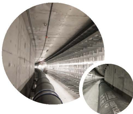
河南省郑州市龙湖金融中心综合管廊项目 DN500 3公里K等级供水管道
