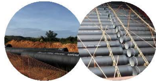
赞比亚Mulonga项目 球墨铸铁供水管道和管件 DN500-DN1200 16.7公里
