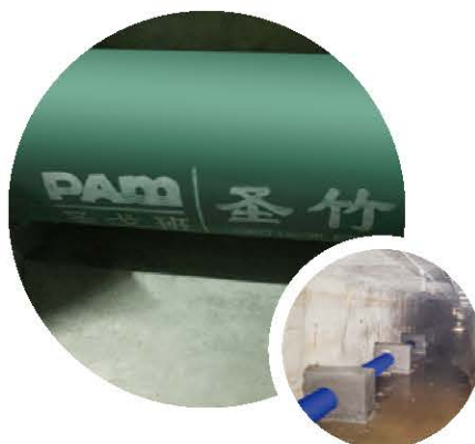
山东省日照市地下综合管廊项目 DN300-DN600 6.7公里 C等级供水管道
