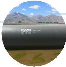
西藏自治区拉萨市纳金水厂 原水输送管线工程 DN1600 3公里
