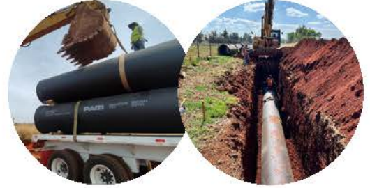
墨西哥Presa El Salto Calderon项目 C等级球墨铸铁供水管道 DN1000-DN1200 31.47公里
