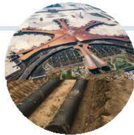
北京新机场白家务水源地迁建项目 廊坊市(固安)水源地工程 DN200-DN800 87公里
