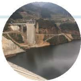
贵州省册亨水库供水灌溉工程 DN500-DN1400 35公里
